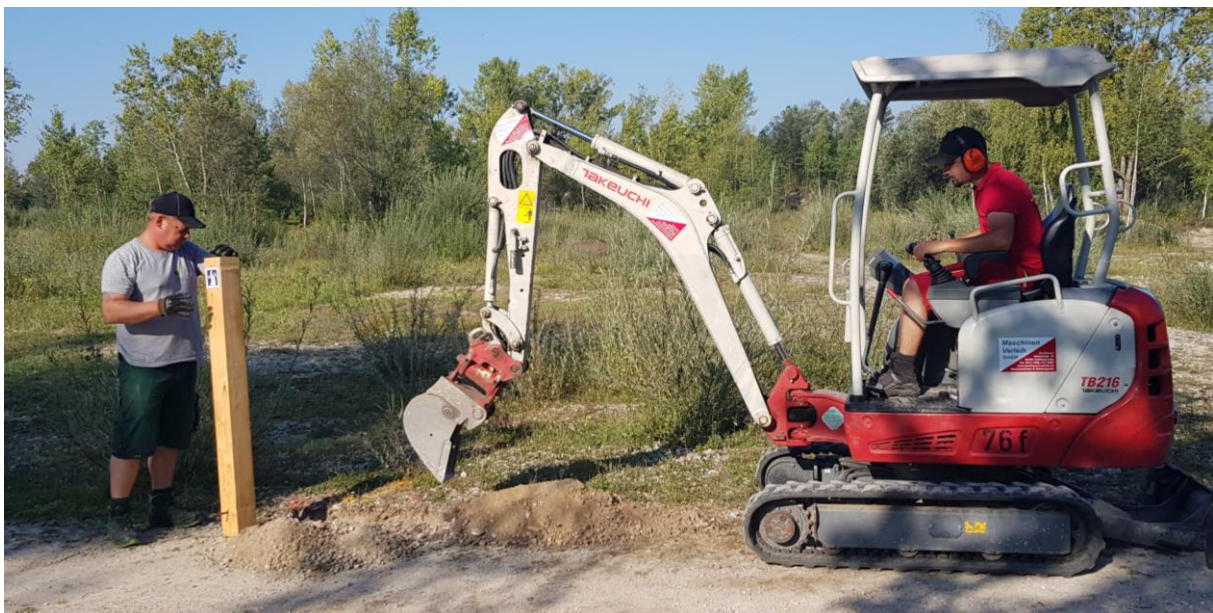
Setzen der Markierungspfosten (Quelle: HFV)
